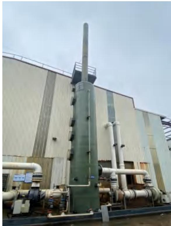
硫酸高铁、胶体制备硫酸雾废气排放口
