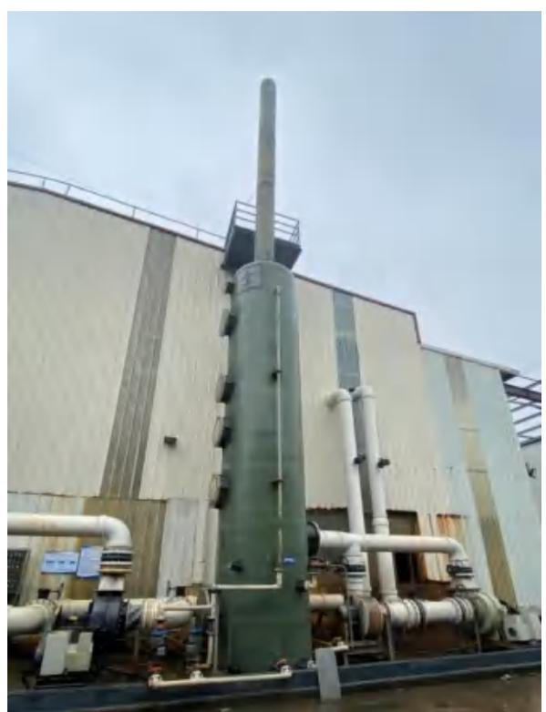
硫酸高铁、胶体制备硫酸雾废气处理设施
