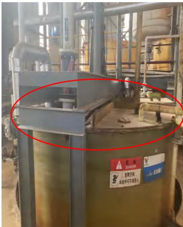
胶体制备桶：反应桶加盖密闭集气
