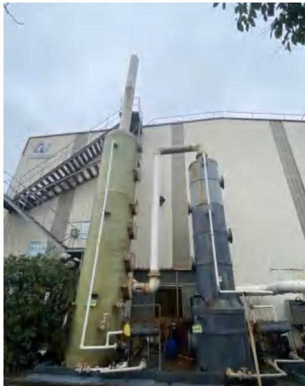
硫酸亚铁制备硫酸雾废气处理设施
