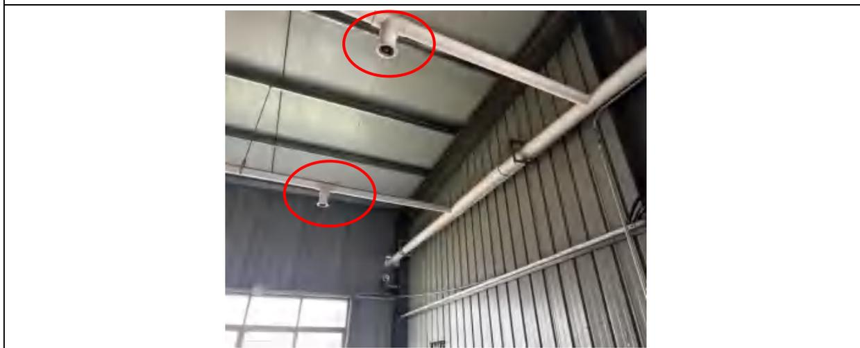
危废仓库废气：多点位集气罩+车间整体抽气
